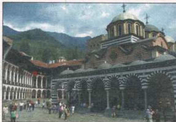
Das berühmte Rila-Kloster im südwestlichen Bulgarien wird im Rahmen einer ADAC Campingreise angesteuert.
